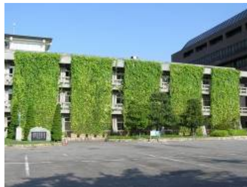
■イメージ例：壁面緑化／安城市
